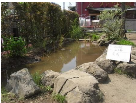
改修後の止水部分
