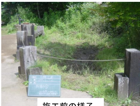
施工前の様子
